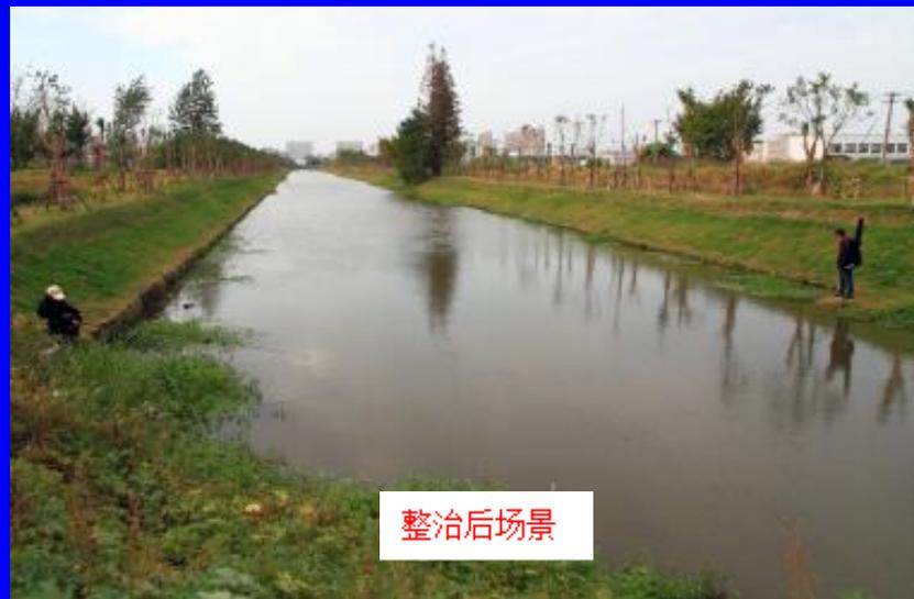
城南新区五星中伏河西起一号沟，东至大新河，全长960m。河道中心线基本沿老河线布置，整治后河底宽6m，河底高程-1.5m，边坡1:2，两侧实施驳岸、游路、亲水平台以及景观绿化，全线进行清淤。河道两侧密打圆木桩实施生态护坡，埋设 $\Phi$  400—600污水管道进行截污。工程总投资1800万元。
