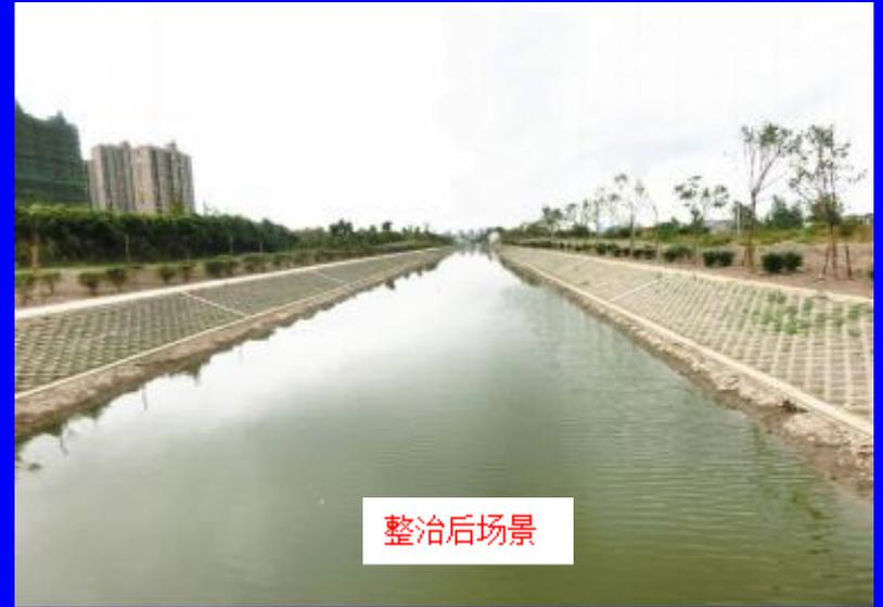
盐都区郝庄河东至小马沟，西至大马沟，全长2.08km。由于河坡水土流失，河床逐年抬高，河道淤积严重。2014年，市、区政府将郝庄河列为城市河道整治实事工程，并于2015年2月初开始实施，8月底完成。工程主要包括疏浚河道、生态护岸、截污绿化及游路工程等，总投资3710万元。
