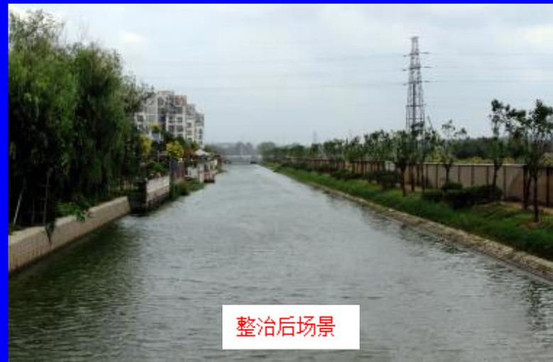
城南新区北中沟河道整治工程西起大新河，东至东伏河，全长1300m，规划红线宽度26—30m（含驳岸、游路、绿化），河道上口宽度18—22m。河道中心线基本沿老河线布置，整治后河底宽6m，河底高程-1.5m，边坡1:2，两侧实施驳岸、游路以及景观绿化，全线清淤。工程总投资2500万元。
