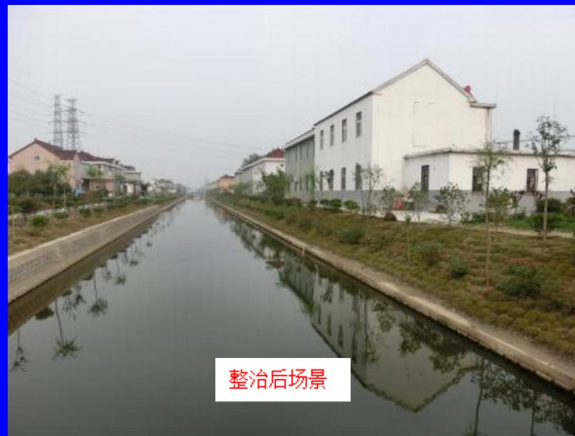
盐都区北港河西至大马沟，东至西环路，全长3.53km。由于河坡水土流失，河床逐年抬高，河道淤积严重。2013年，市、区政府将北港河列为城市河道整治实事工程，并于2014年3月开始实施，11月完成。工程主要包括疏浚河道、生态护岸、截污绿化及游路工程等，总投资4565.7万元。
