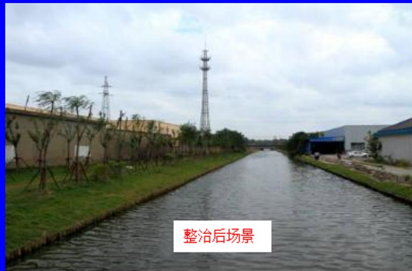
城南新区南中沟整治工程西起串场河，东至东伏河，全长2240m。河道中心线基本沿老河线布置，整治后河底宽8m，河底高程-1.5m，边坡1:2，两侧实施驳岸、保洁码头以及景观绿化，全线进行清淤。其中开放大道—兴业路、文港路—东伏河段两侧密打圆木桩实施生态护坡，河道两侧埋设 $\Phi$ 400—600污水管道进行截污。工程总投资2400万元。
