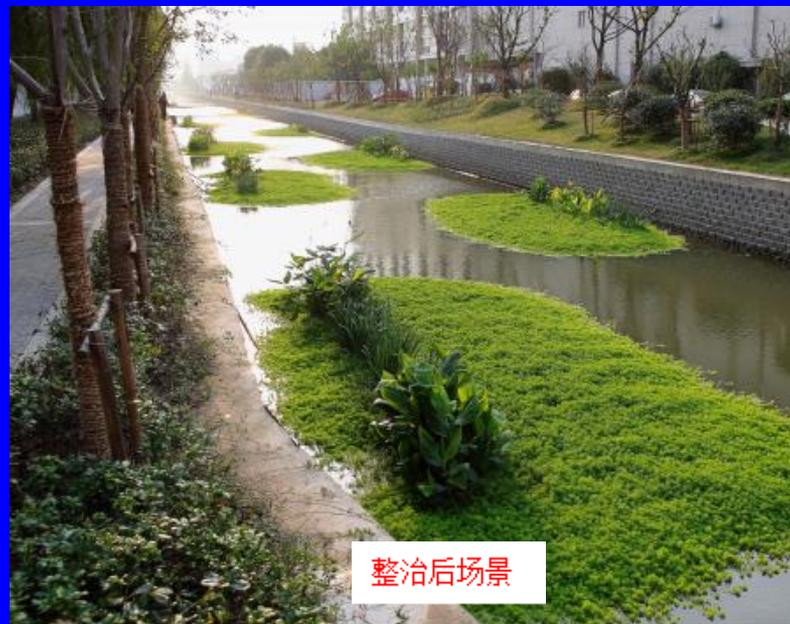
城南新区北港河西至西环路，东至串场河，全长2.9km。由于河坡水土流失，河床逐年抬高，河道淤积严重。2013年，市、区政府将北港河列为城市河道整治实事工程，并于2014年3月开始实施，10月完成。工程主要包括疏浚河道、生态护岸、截污绿化及游路工程等，总投资约4700万元。
