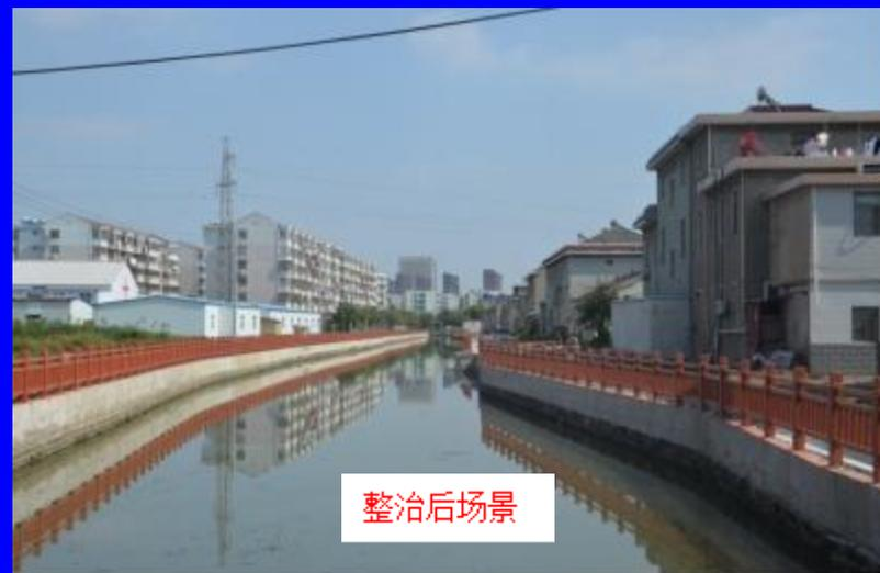
亭湖区铁家港西起铁家港，东至油坊沟，全长0.81km。该河由于长期未疏浚，加上河两岸生产、生活污水直排等因素，河水常年发黑发臭，严重影响两岸居民生产、生活。2013年，市、区政府将铁家港列为城市河道整治实事工程，并于2015年3月开始实施，10月完成。工程主要包括疏浚河道、生态护岸、截污绿化及游路工程等，总投资3840万元。
